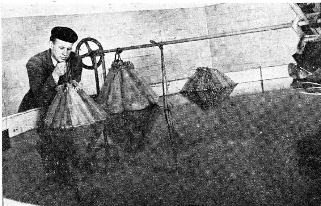
Obr. 3. Máčení vzorků v náduvníku (silonové sáčky při spouštění do vody)
