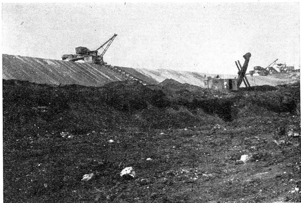
4. Skryvka nadložních vrstev korečkovým bagrem a počínající těžba lignitu lžicovým bagrem
