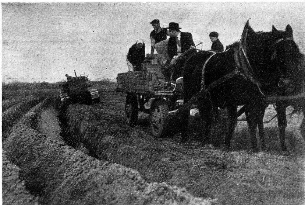
3. Organizace práce při zaorávání vrstvy v hloubce 60 cm.
