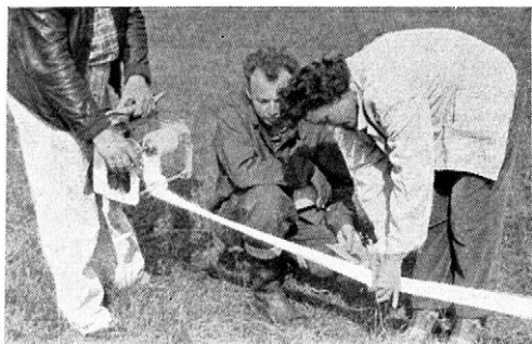
11. Napínání papírových pásů v terénu pomocí navijáku
