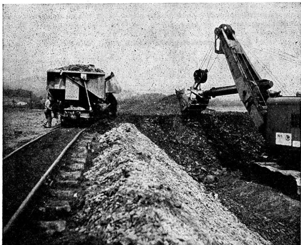
3. Zakládání výsypky rypadlovým způsobem v SHD
